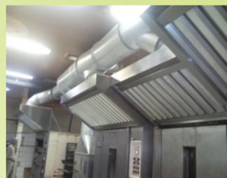
As coifas exaustoras auxiliam na retirada da fumaça e através dos filtros inerciais, condensam a gordura para que haja a drenagem, coleta e descarte.
